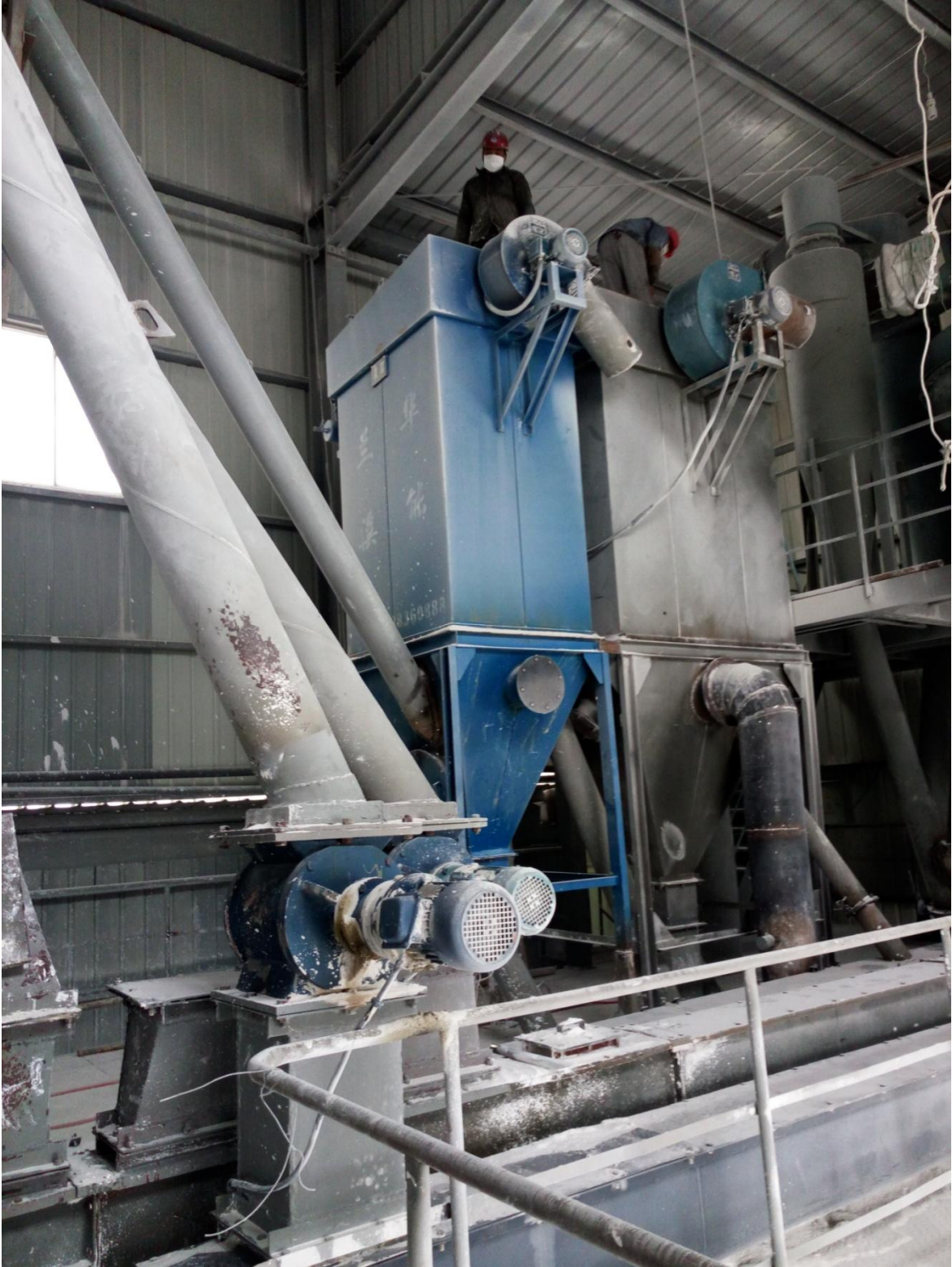
球磨机除尘排气筒整改前：
